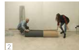
2 Stendere il tappetino Lay the underlayer
