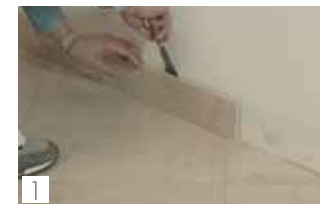
1 Eliminare il battiscopa Remove skirting
